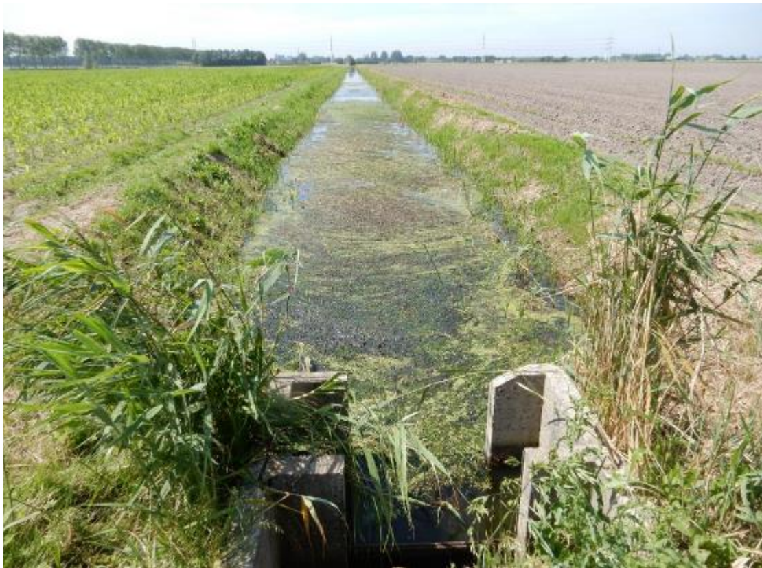
Afbeelding 4: Schotbalkstuw aan eind van infiltratiesloot.
