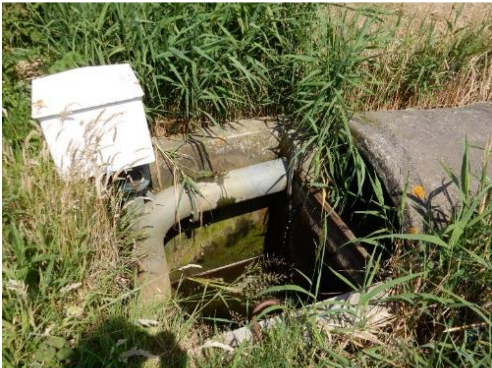
Afbeelding 3: Foto van opmalingsinstallatie van perceel te Vijfhuizen
