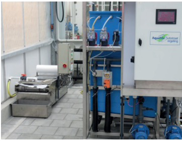
Figuur 3 Techniek voor waterbehandeling in demonstratieruimte (v.l.n.r. vlakbedfilter, substraatunit, ozon-ontsmetting, substraatunit en microfilter).
