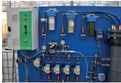
Figuur 3 Techniek voor waterbehandeling in demonstratieruimte (v.l.n.r. vlakbedfilter, substraatunit, ozon-ontsmetting, substraatunit en microfilter).
